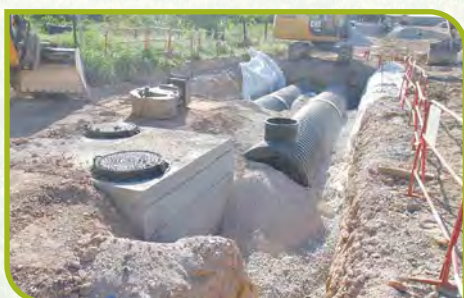
POSE DE TUYAUX DE RÉTENTION ET D'INFILTRATION DES EAUX PLUVIALES
