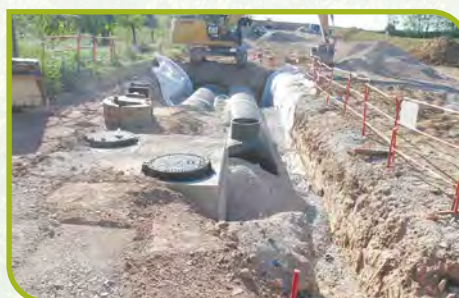
POSE DE TUYAUX DE RÉTENTION ET D'INFILTRATION DES EAUX PLUVIALES
