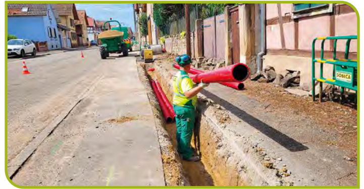
POSE DU RÉSEAU ÉLECTRIQUE POUR LA DÉSERT DU LOTISSEMENT
