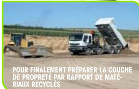
**POUR FINALEMENT PRÉPARER LA COUCHE DE PROPRETÉ PAR RAPPORT DE MATÉRIAUX RECYCLÉS**
